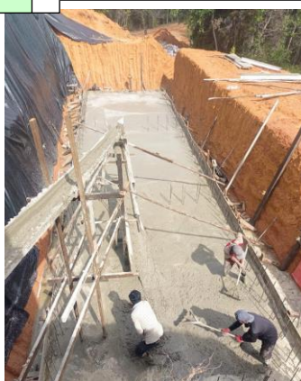
De fundering en vloer van nog een enorme ondergrondse watertank om al het regenwater op te vangen dat wordt gebruikt als drinkwater in de verschillende huizen in de omgeving. Dit wordt onze 14e ondergrondse watertank.
